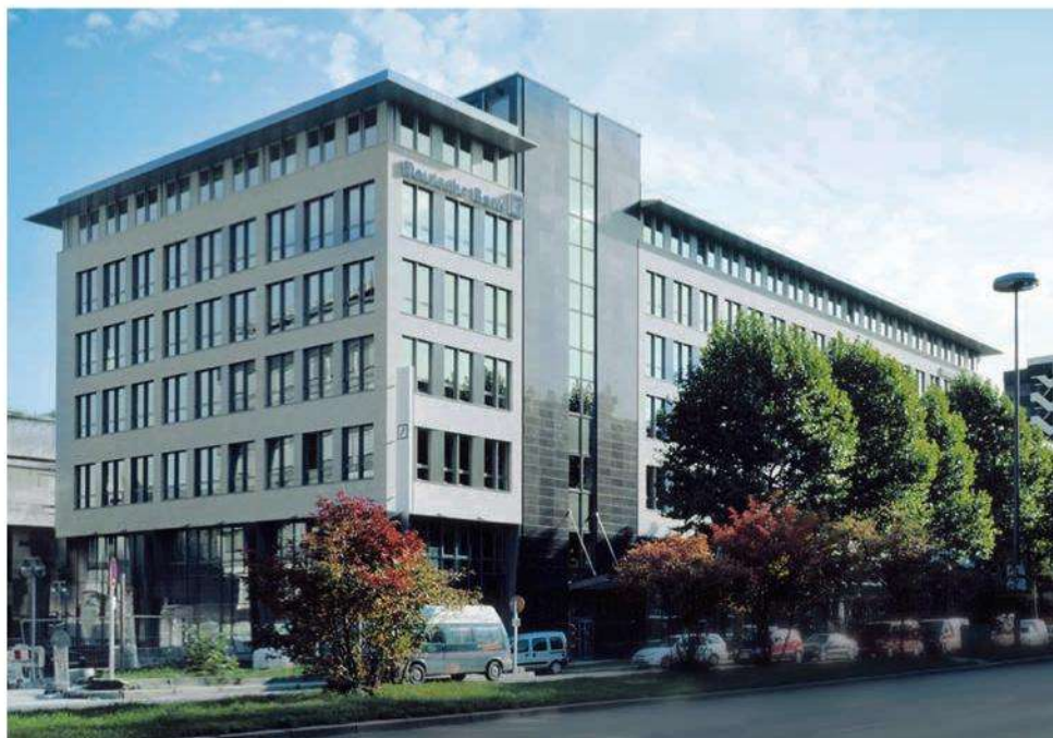
In Stuttgart befindet sich eine der Gründungsinvestitionen des Core 4
